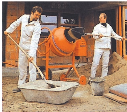
Рис. 92. Приготовление бетона — суспензии песка и цемента в воде
