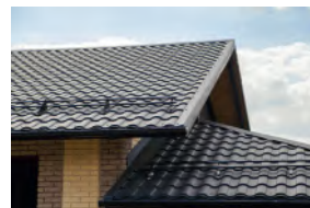
Полимерное покрытие на металлочерепице
